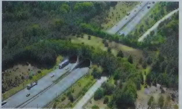
▼ Figure 56.18 Un corridor de déplacement artificiel. Ce pont construit aux Pays-Bas permet aux animaux de traverser un obstacle créé par les humains.
