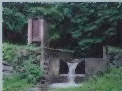
(a) Les chercheurs ont fait construire des barrages et des déversoirs de béton en travers des ruisseaux qui drainaient les bassins versants de Hubbard Brook. Ils ont ainsi pu mesurer les sorties d'eau et de nutriments minéraux de l'écosystème.
