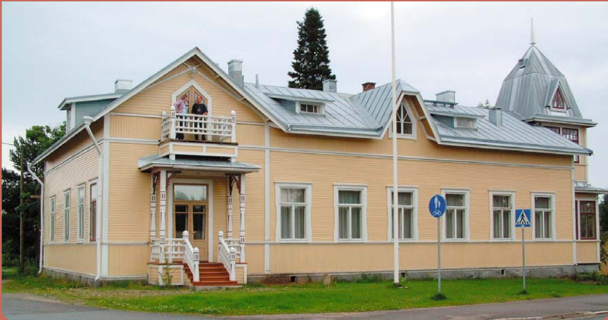
Via ry, Wanha Apteekintalo (rakennettu 1911), Ristisolan tie 1
