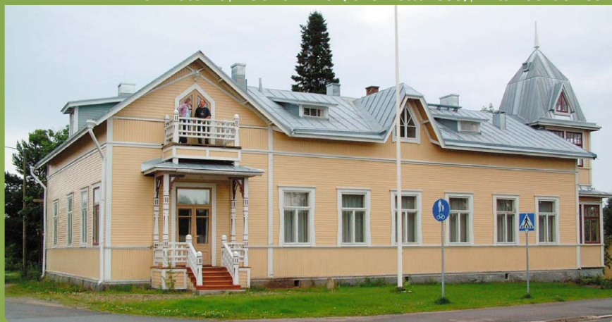
Via ry, Wanha Apteekintalo (rakennettu 1911), Ristisointie 1
