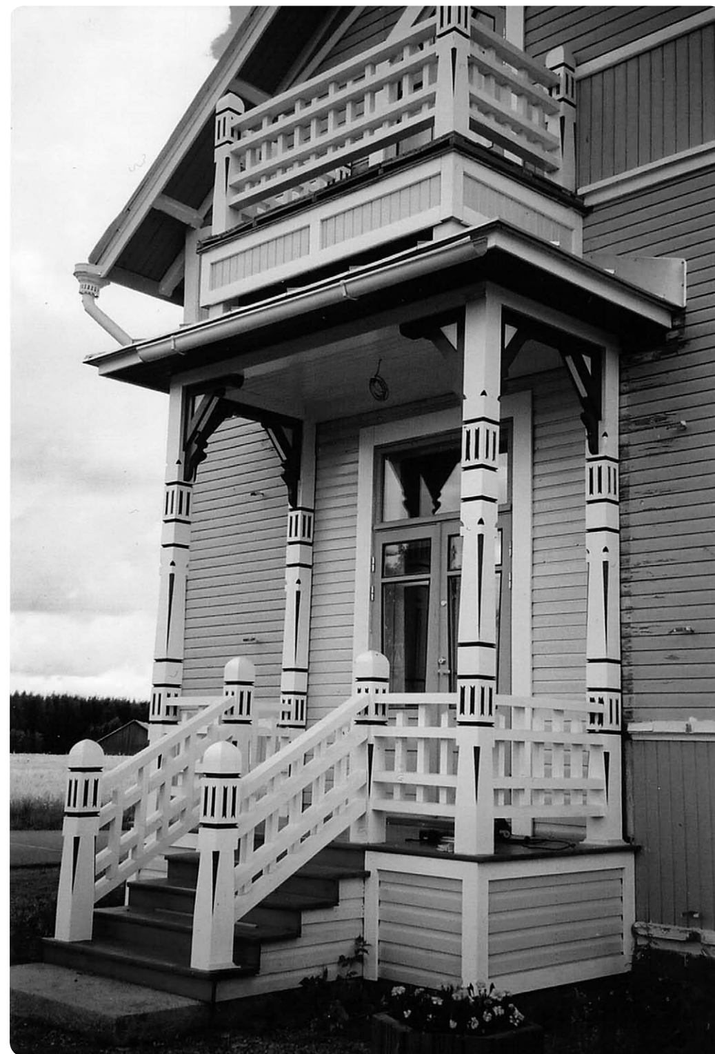
50-luvulla Apteekintalon osti Pohjoismaiden yhdyspankki, joka purki julkisivun puoleisen parvekkeen ja kuistin pois ja rakennutti tilalle lasieteisen. Via ry entisöi talon ja palautti julkisivun parvekkeen ja koristepylväskuistin koristemaalauksineen.
