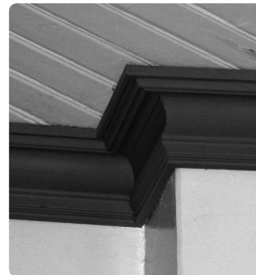
Huoneiden kattolistat höylättiin Varkaudessa Hasintien Puu -yrityksessä Apteekintalolta saadun mallin mukaan. Yrittäjä kertoi myöhemmin, että malli osoittautui niin hyväksi, että sitä on ryhdytty käyttämään entisöitävissä kohteissa yleisemminkin.
