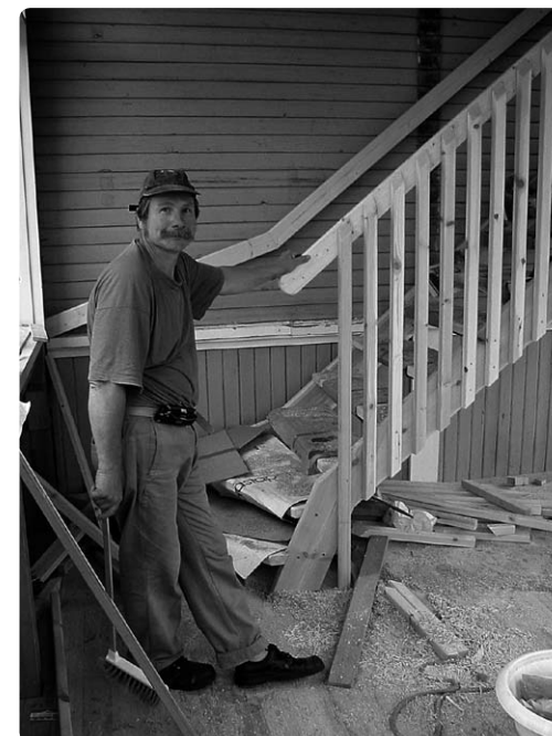
Wanhan Apteekintalon paloportaait sijoitettiin komeaan torniin (katso s. 142). Rakennusmestari Pauli Sipilä suunnitteli tyylikkääst puuportaait ja rakensi ne itse.
