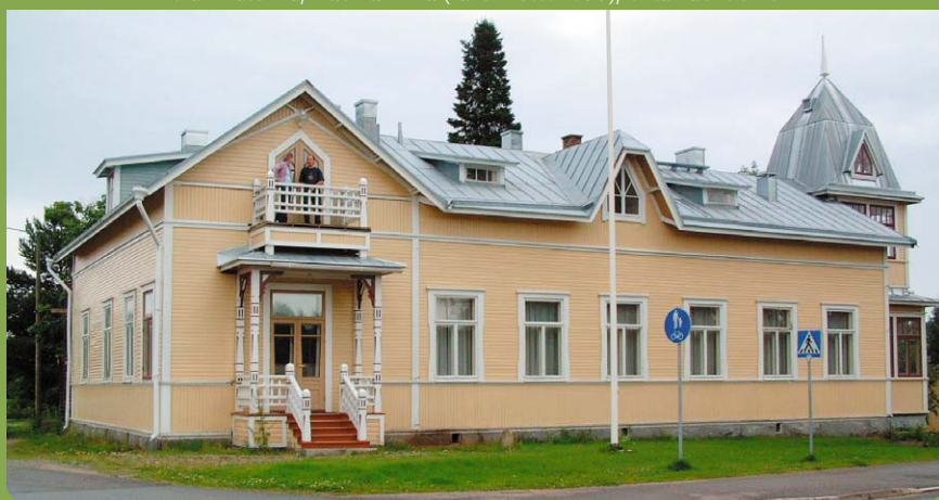
Via ry, Wanha Apteekintalo (rakennettu 1911), Ristisolangtie 1
