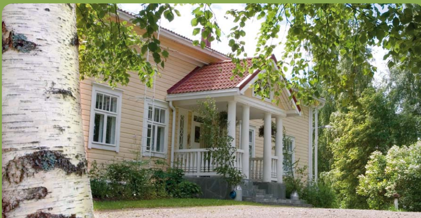
Via-Akatemia, Kaukalinna (rakennettu 1853), Viitamäentie 189
