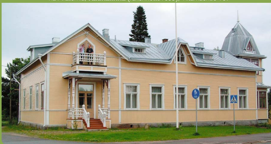
Via ry, Wanha Apteekintalo (rakennettu 1911), Ristisolangtie 1
