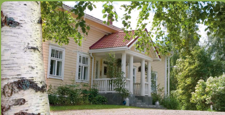
Via-Akatemia, Kaukalinna (rakennettu 1853), Viitamäentie 189
