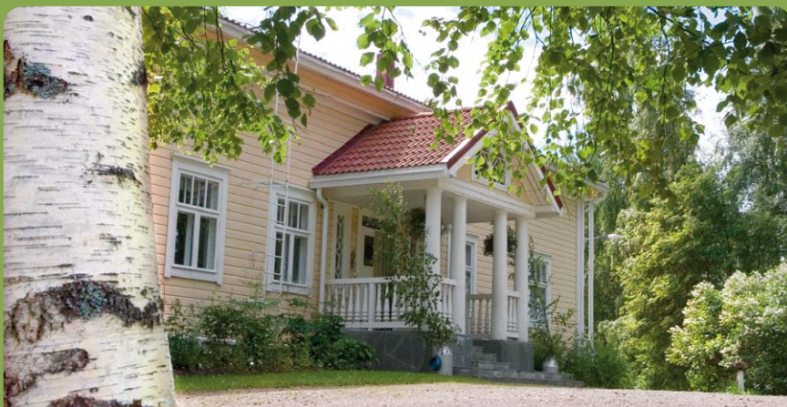
Via-Akatemia, Kaukalinna (rakennettu 1853), Viitamäentie 189
