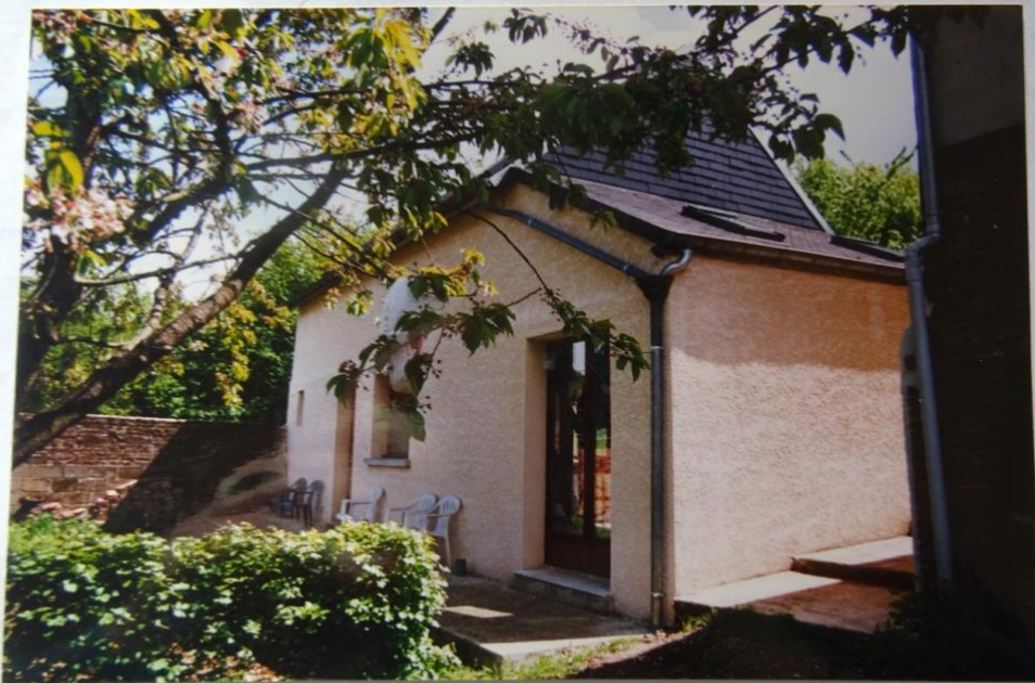
Après les travaux
