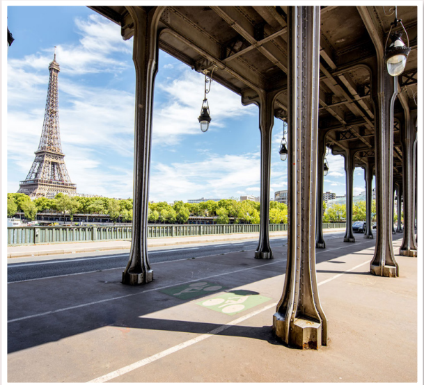
14- PUENTE BIR HAKEIM
