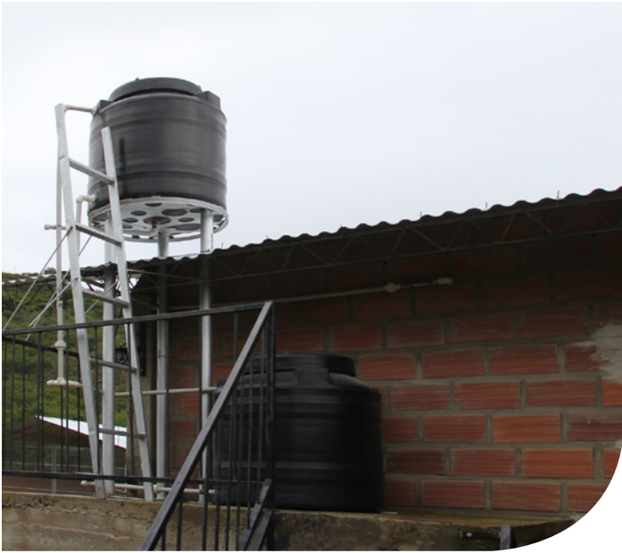
RÉSERVOIR D'EAU AU-DESSUS D'UN POULAILLER
