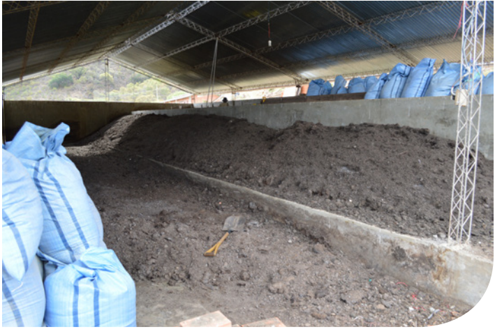
VUE D'ENSEMBLE DE LA COMPOSTIÈRE
