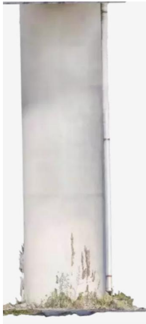
Vista del elemento desde el lado Sur
