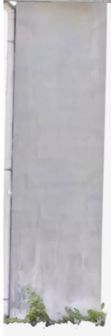
Vista del elemento desde el lado Sur
