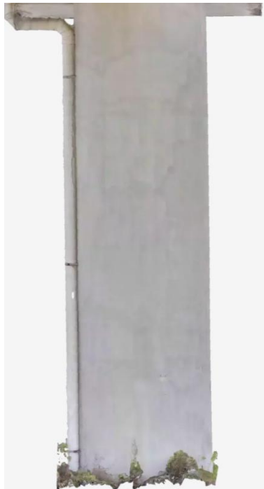
Vista del elemento desde el lado Norte
