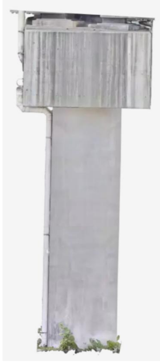
Vista del elemento desde el lado Sur
