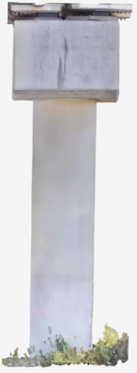
Vista del elemento desde el lado Norte
