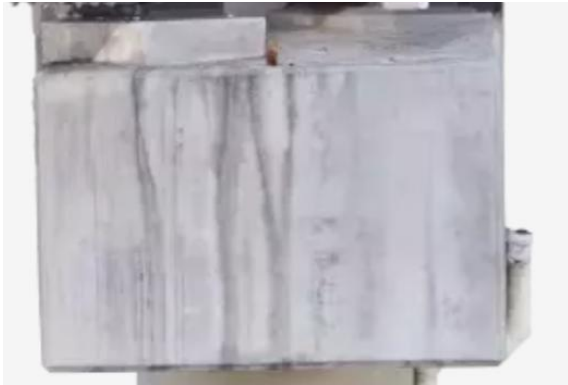
Vista del elemento desde el lado Sur
