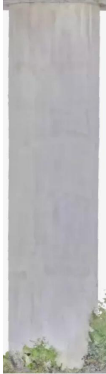
Vista del elemento desde el lado Norte
