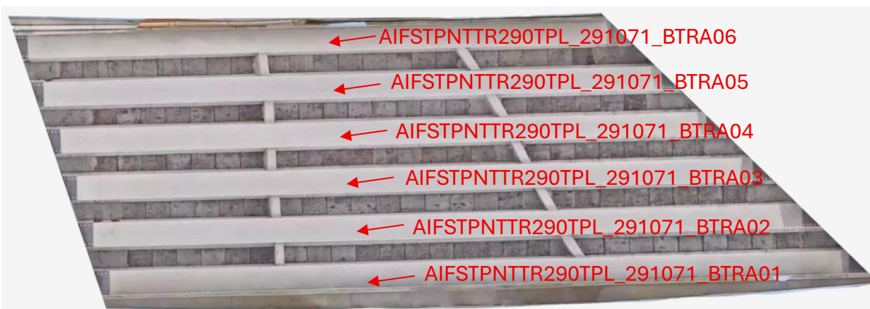
Vista del la Superficie Inferior de Superestructura
