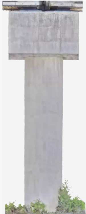
Vista del elemento desde el lado Norte
