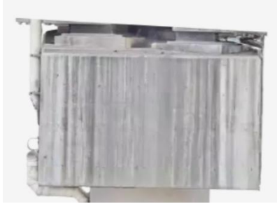
Vista del elemento desde el lado Sur
