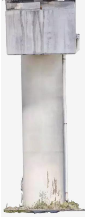
Vista del elemento desde el lado Sur
