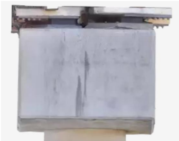
Vista del elemento desde el lado Norte
