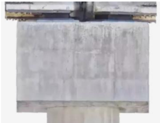
Vista del elemento desde el lado Norte
