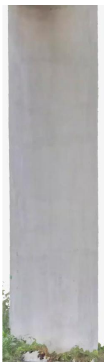
Vista del elemento desde el lado Sur
