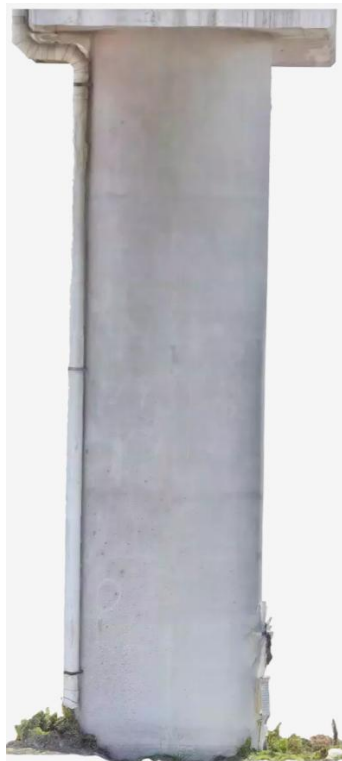
Vista del elemento desde el lado Norte
