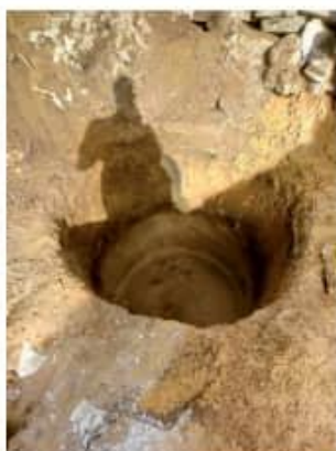
Etape 1: Creuser le trou de la fosse et du puisard après avoir situé où la fosse restera dans la maison
