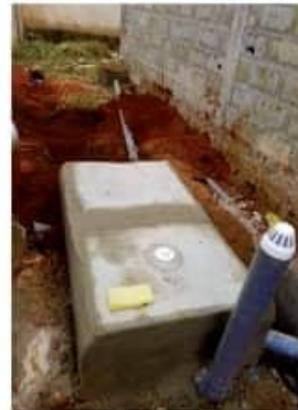
Etape 16: NB: Ne jamais oublier le tuyaux d'aération de la fosse biofil
