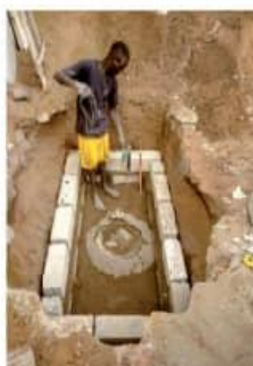
Etape 2: Installation de la fosse biofil
