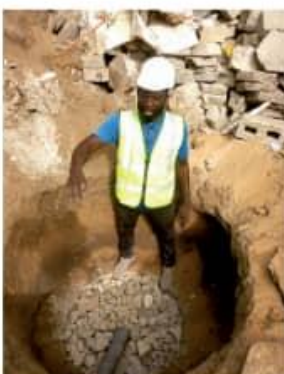
Etape 11: Remplissage du puisard non vidangeable avec des concassés
