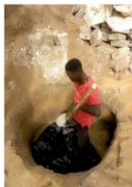
Etape 12: Protection du tuyau sortant de la fosse avec du sachet noir
