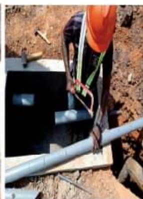
Etape 4: Installation des tuyaux d'évacuation vers la fosse et vers le puisard
