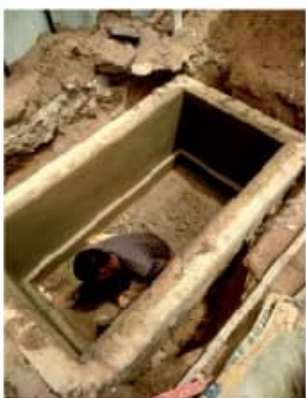
Etape 3: Crépissage de l'intérieur de la fosse en donnant la pente évacuation d'eau vers le puisard
