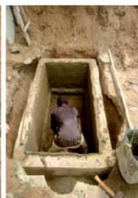
Etape 2: Installation de la fosse biofil
