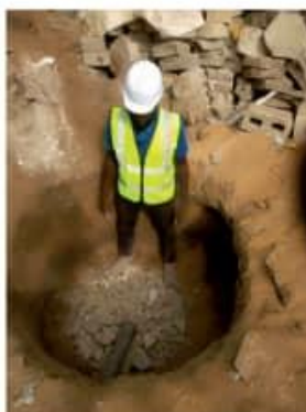
Etape 11: Remplissage du puisard non vidangeable avec des concassés
