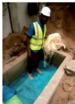
Etape 8: Installation de grillage fin et filasse
