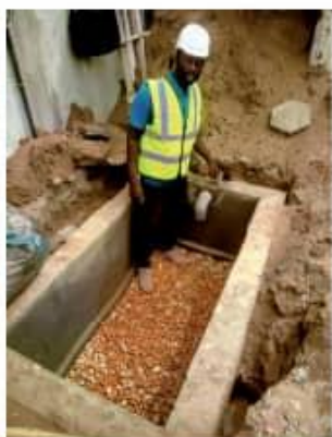
Etape 3: Crépissage de l'intérieur de la fosse en donnant la pente évacuation d'eau vers le puisard
