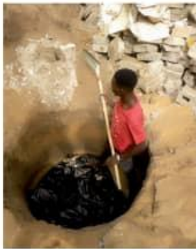
Etape 13: Remblaiage du puisard et pose de la dalle de la fosse biofil
