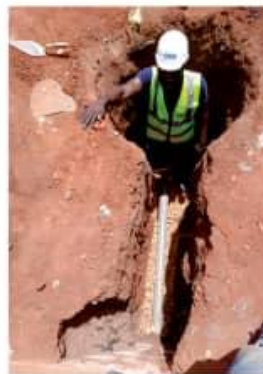
Etape 10: Installation du puisard non vidangeable
