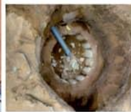
Etape 10: Installation du puisard non vidangeable
