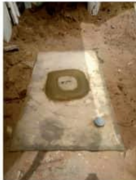
Etape 15: Fermeture de la fosse après avoir versé le bio master à l'intérieur
