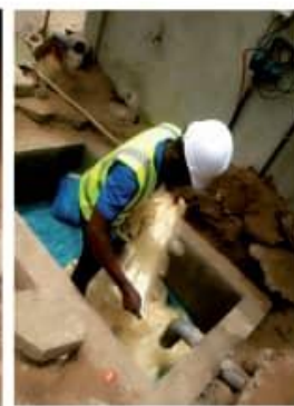
Etape 8: Installation de grillage fin et filasse
