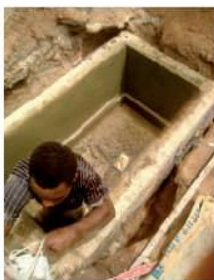
Etape 3: Crépissage de l'intérieur de la fosse en donnant la pente évacuation d'eau vers le puisard
