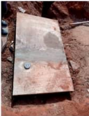
Etape 15: Fermeture de la fosse après avoir versé le bio master à l'intérieur
