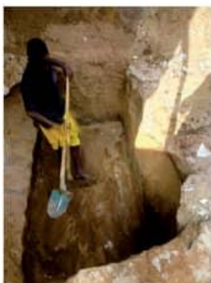
Etape 1: Creuser le trou de la fosse et du puisard après avoir situé où la fosse restera dans la maison
