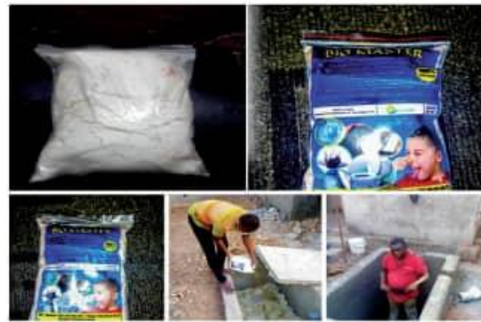
Etape 14: Après l'installation de la dalle de la fosse verser le bio master à l'intérieur de la fosse
