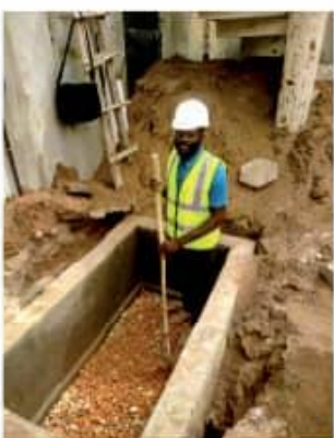
Etape 5: Installation des graviers
