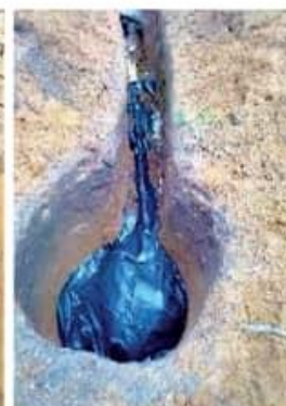
Etape 12: Protection du tuyau sortant de la fosse avec du sachet noir
