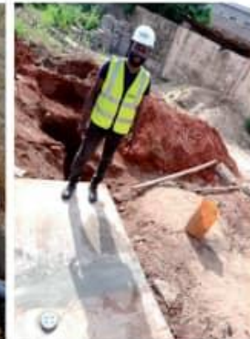
Etape 16: NB: Ne jamais oublier le tuyaux d'aération de la fosse biofil
